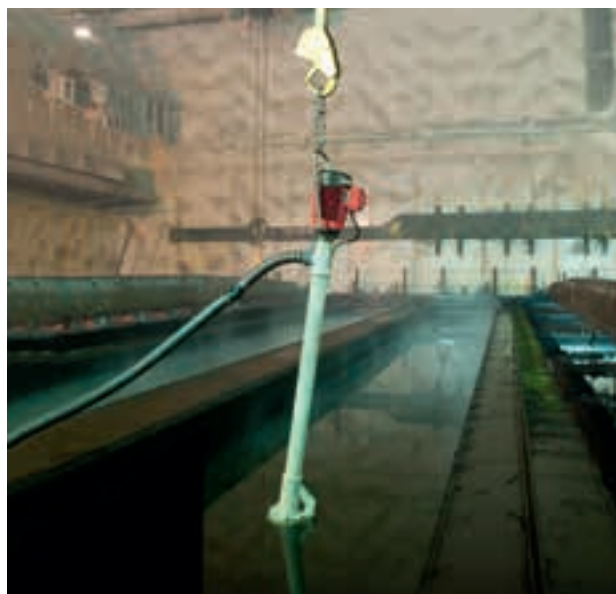
F 640 - Pompaggio di acido solforico diluito da vasca di decapaggio.
